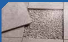
Pokládka na štěrk / písek
